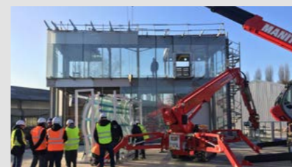
Mock Up Wellenglasfassade: Einbau des ersten gewellten Glaspaneels
